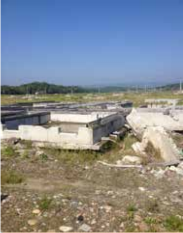
津波被害により基礎以外 流された住宅
